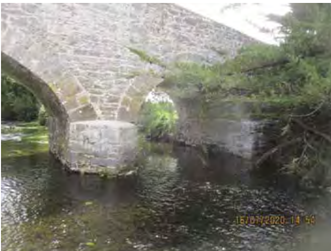
Gilloge River Bridge.
