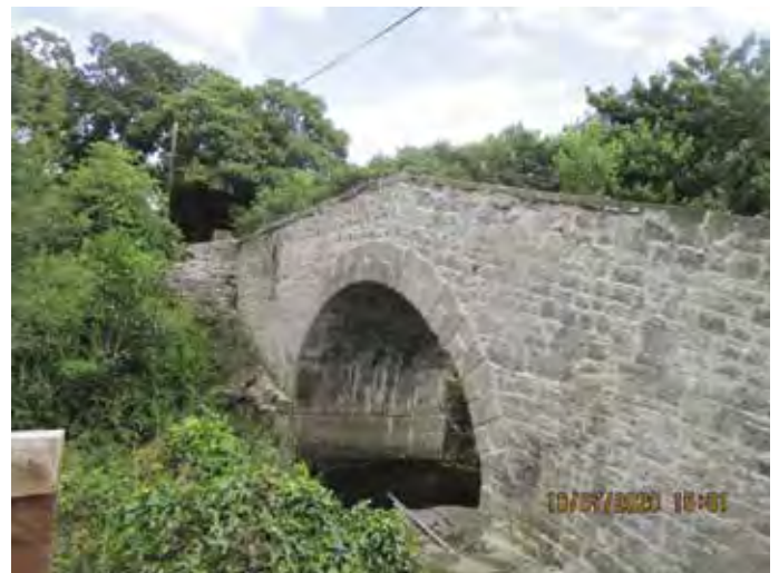
Canal Bridge, Gilloge.
